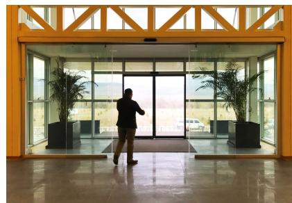
Düzce'de yer alan Bolçi üretim fabrikası ana giriş için rüzgarlık çözümünü; İç tarafta cam detaylı 3000x3000mm kapı ve dış taraf için cephe bağlantılı alüminyum detaylı kapı olarak gerçekleştirmiştir. Giriş kapısında elektronik kilit sistemi (VRR), record RIC 290 AC perde fotoselli radar ile maksimum geçiş güvenliği, record RAD 290 AC radar ile istenilen özelliklerde tetikleme sağlanmıştır.
